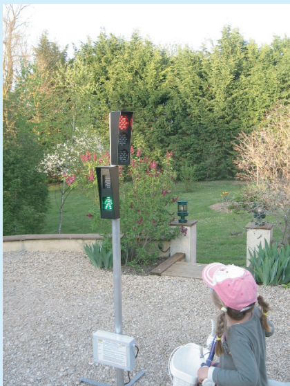
L'automate est placé en bas d'un poteau
